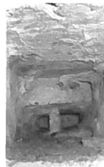
Fig. 17. Et kig ind i et af hullerne, hvor rekylbjælkerne oprindeligt var placeret. Træet er for længe råddnet væk, men det bevarede martelaftryk af bjælken afslører, at tømmeret inderst har haft en bladsamling. Man kan se, at den nederste del af tømmeret har været længst. Tømmer-samlingen har været med taphul. Hullet blev fyldt med mørtel, da tømmeret blev muret i skydeskåret, og ses nu som en fritstående mortelcylinder. Nationalmuseet. Foto: Jørgen Frandsen.
