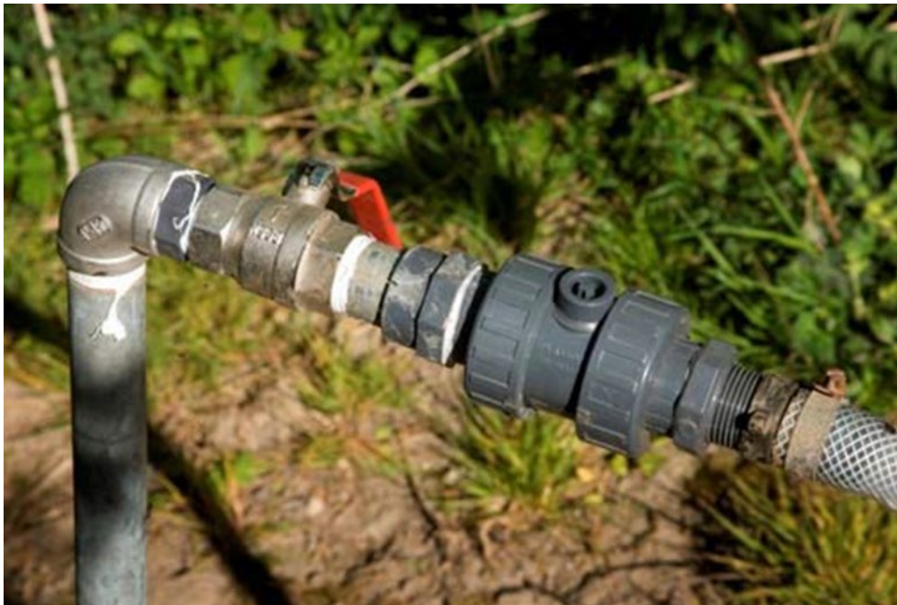
Figur 15. Foto: Jens Tønnesen Fotobureau: Landbrugsmedierne Kontraventil på tapsted er en løsning til at forhindre tilbageløb til ledningsnet
